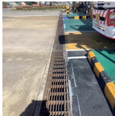
ภาพที่ 2-2 รางระบายน้ำคอนกรีตภายในคลัง
