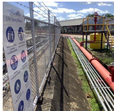
ภาพที่ 2-5 คันคอนกรีตสูง 1.00 เมตร ล้อมรอบลานถังเก็บน้ำมัน
