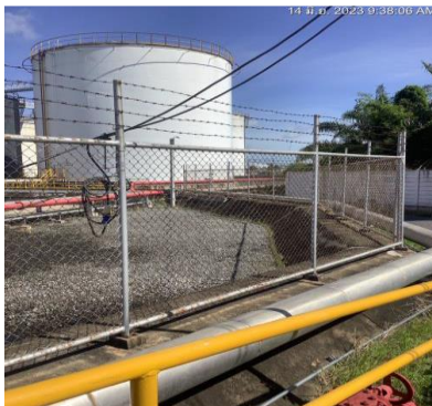
ภาพที่ 2-5 คันคอนกรีตสูง 1.00 เมตร ล้อมรอบลานถังเก็บน้ำมัน
