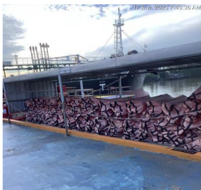
ภาพที่ 2-7 คันคอนกรีตสูง 0.10 เมตร บริเวณหน้าท่า
