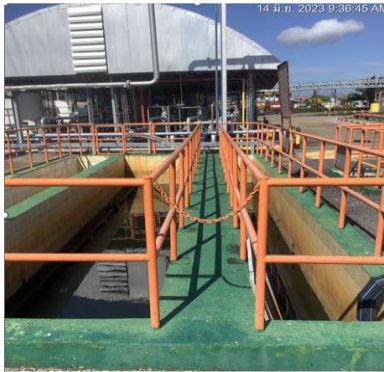
ภาพที่ 2-3 บ่อดักตะกอน (Collection pond)
